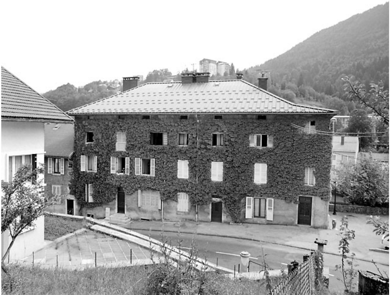
Bâtiment 11-15 rue Pasteur : façade antérieure.
