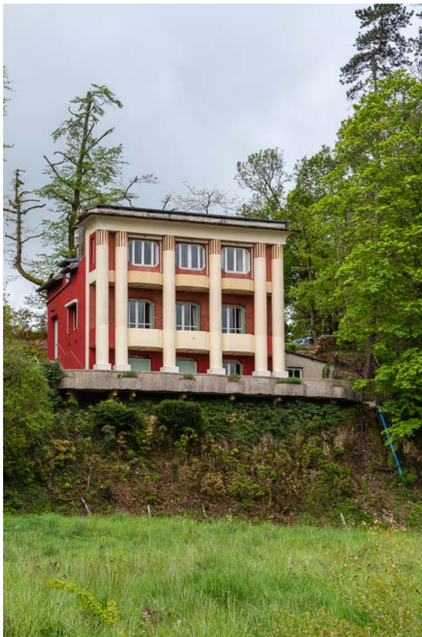
Façade nord, vue de trois quarts.
