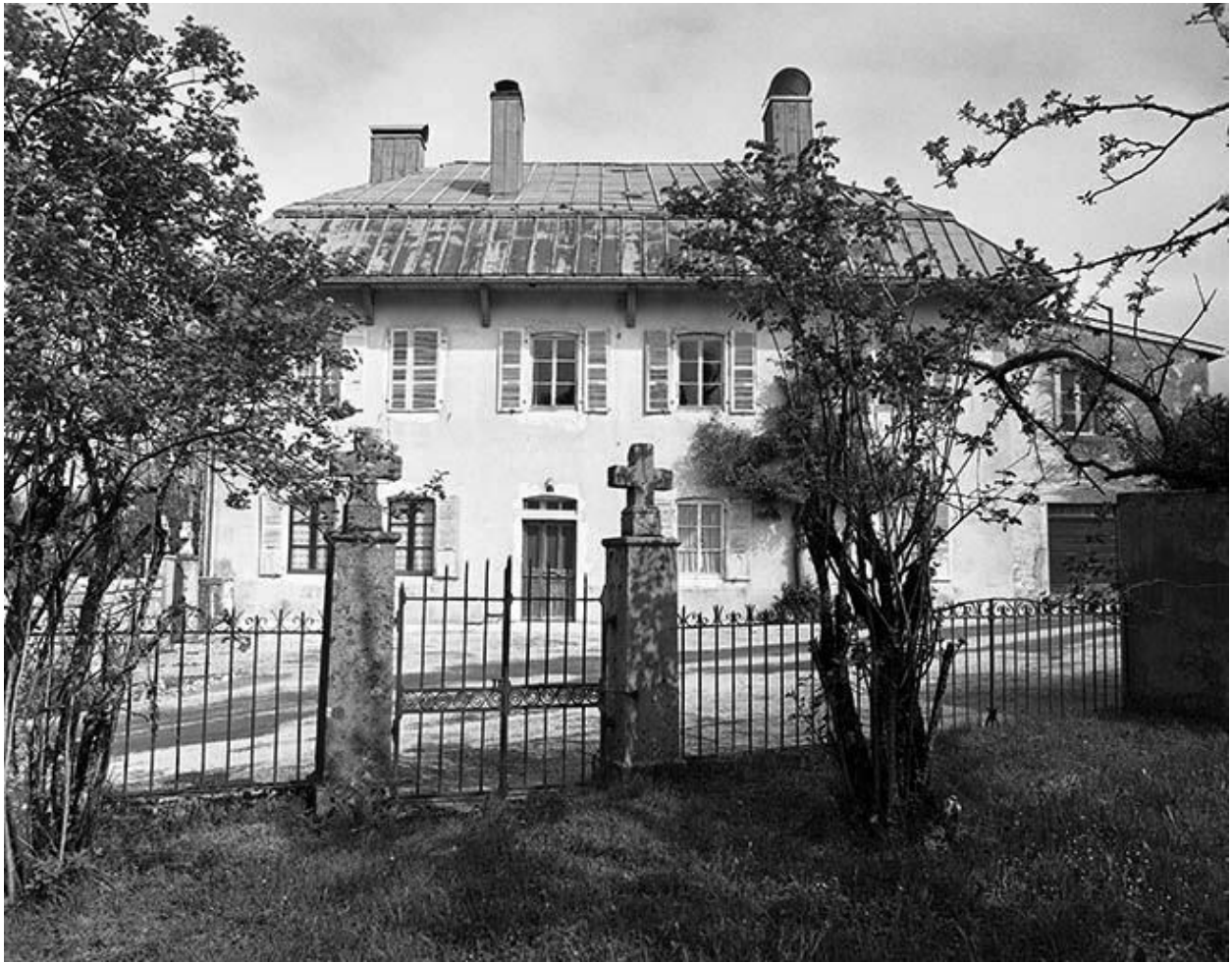
Façade antérieure vue depuis le jardin.
