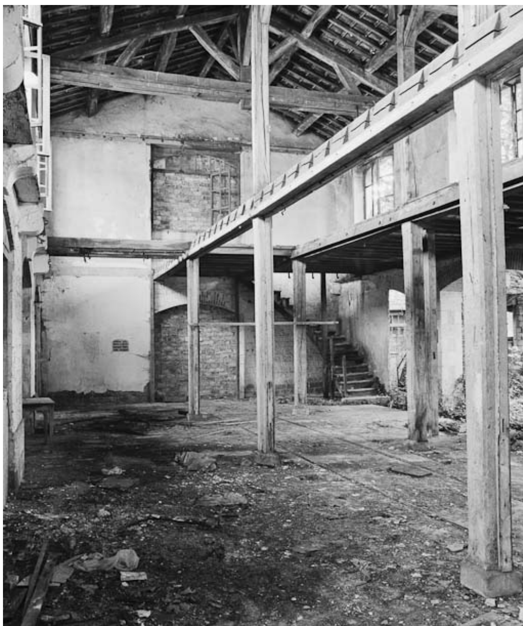
État en 1984, vue intérieure.
