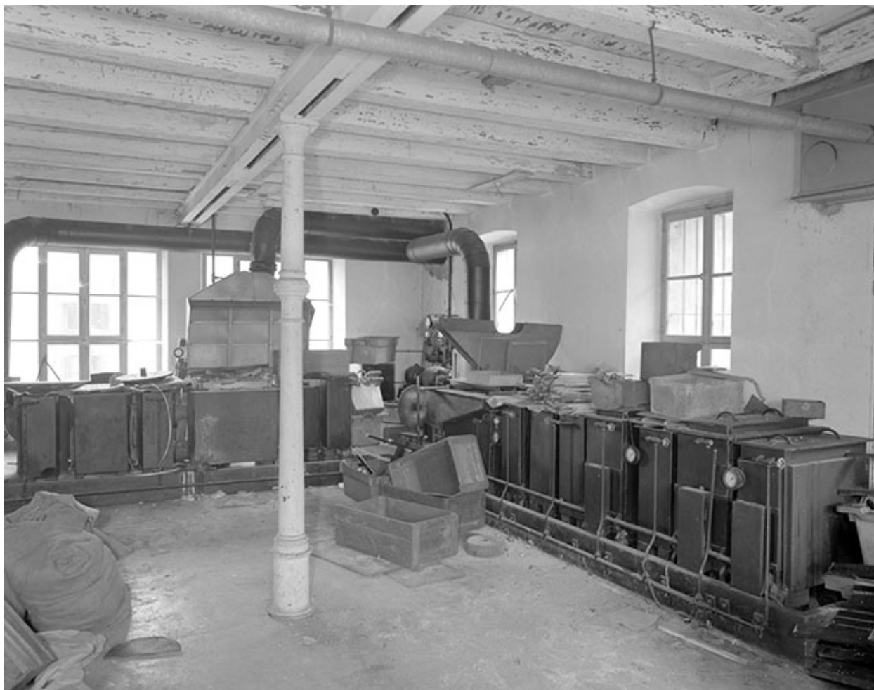
Atelier de fabrication (rez-de-chaussée) : chaîne d'électrolyse.
