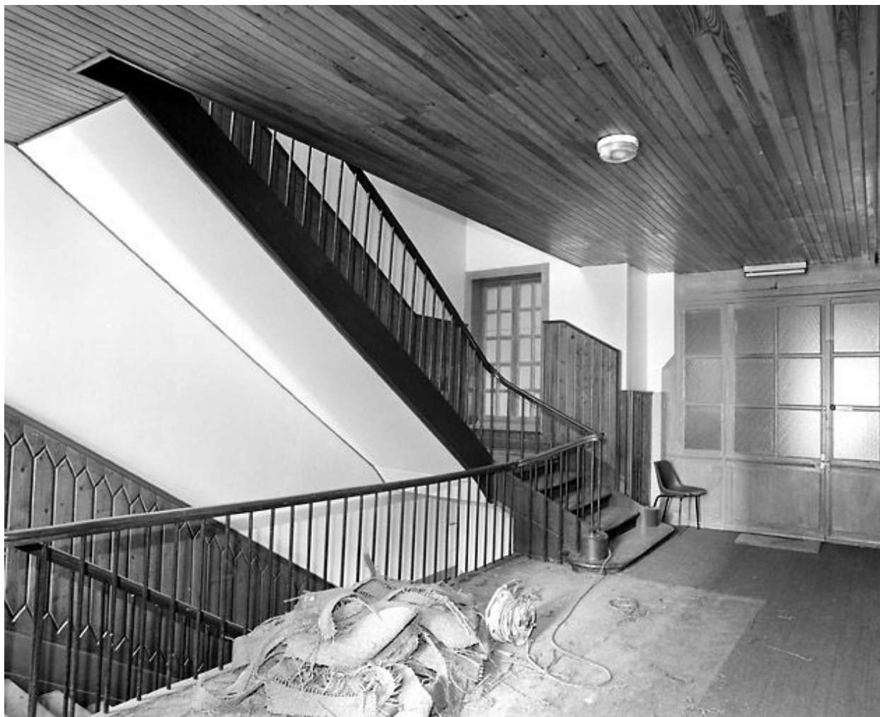
Escalier : un palier.
