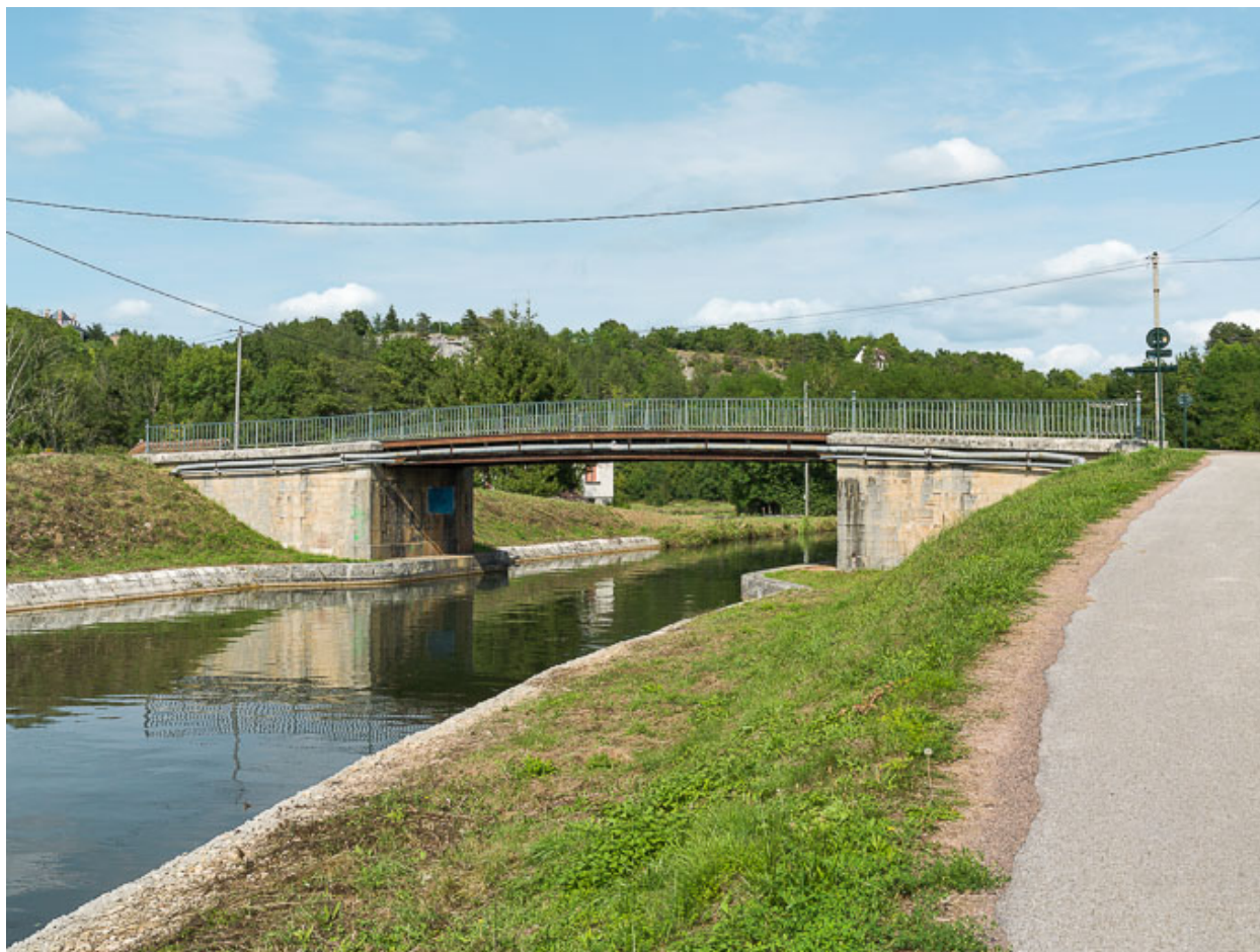
Vue d'ensemble du pont.
