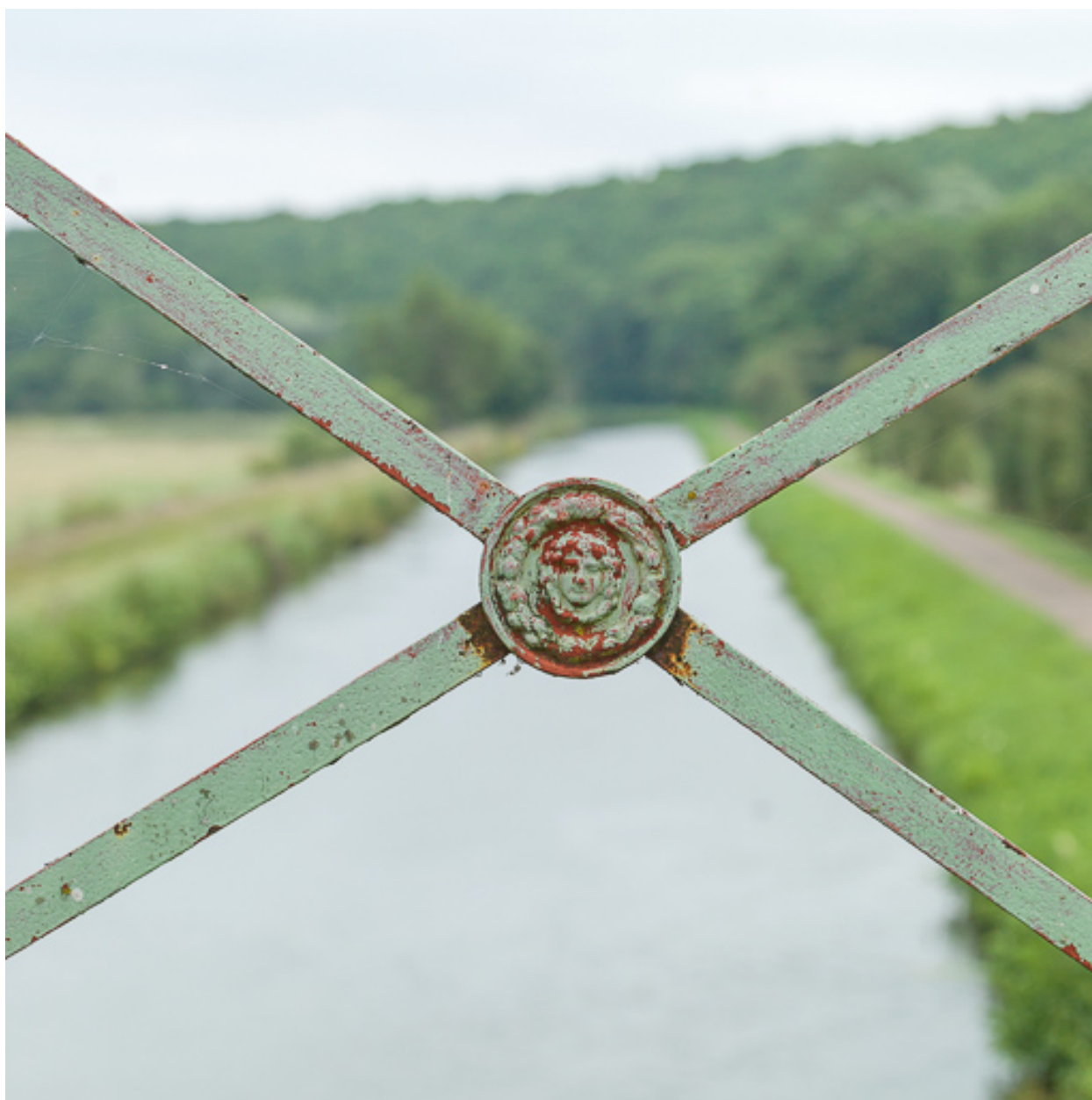
Détail du garde-corps.
