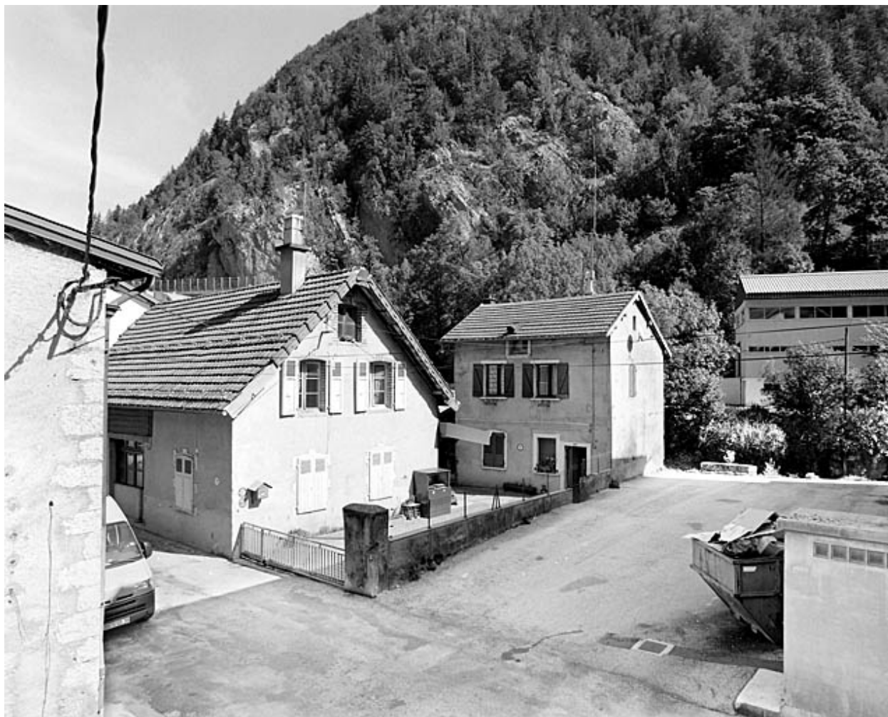
Vue d'ensemble, depuis le sud-ouest : élévations antérieures.
