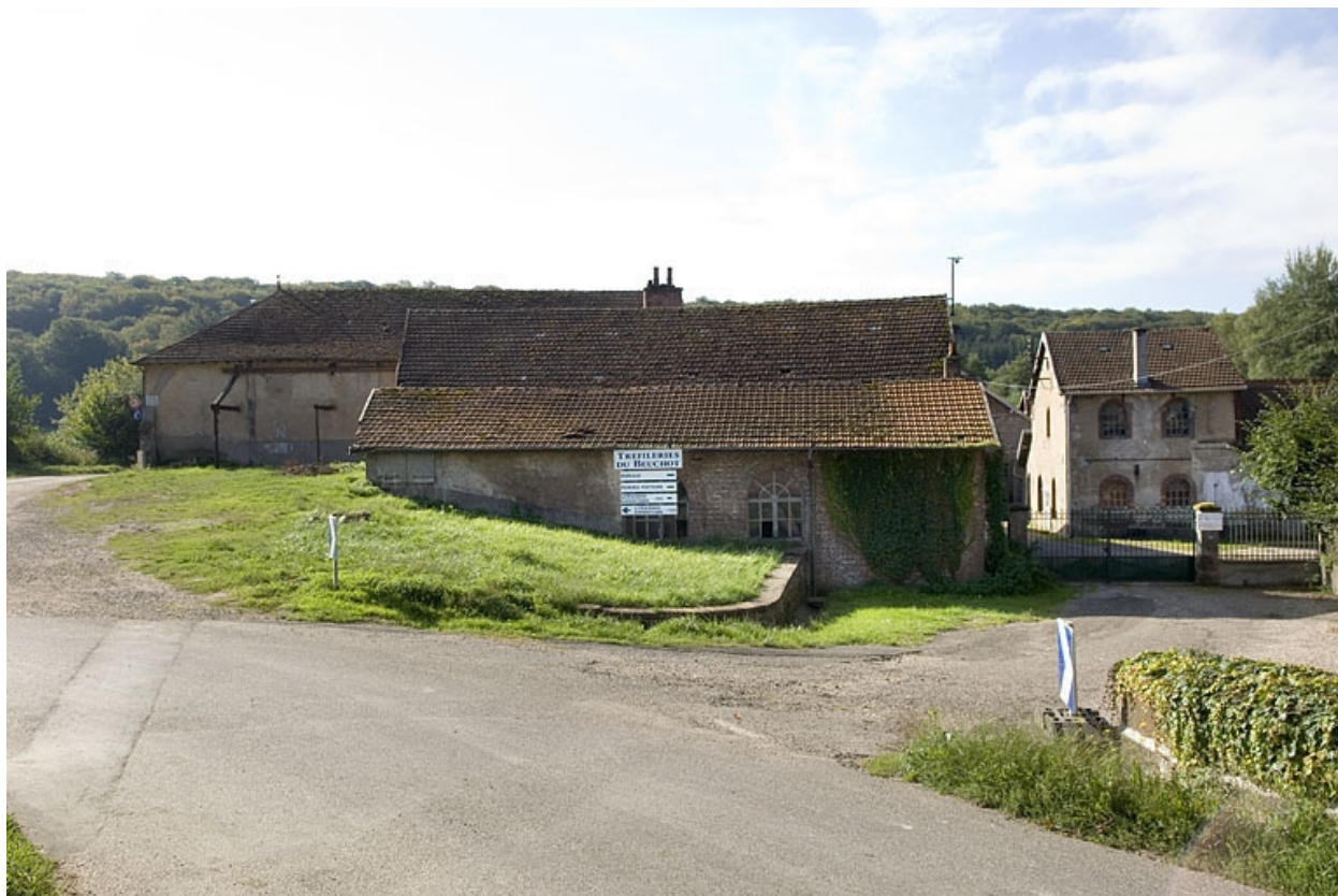
Les bâtiments à l'entrée de l'usine.
