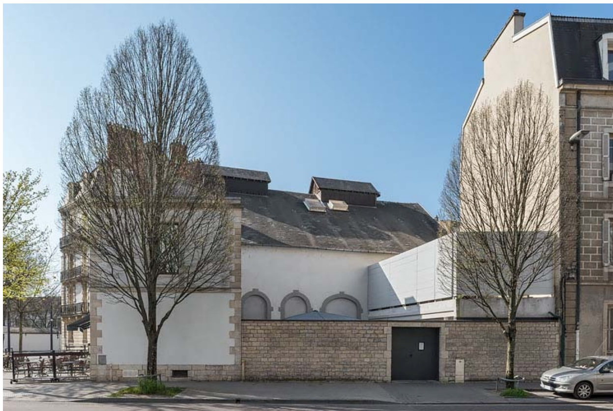
Façade latérale droite.
