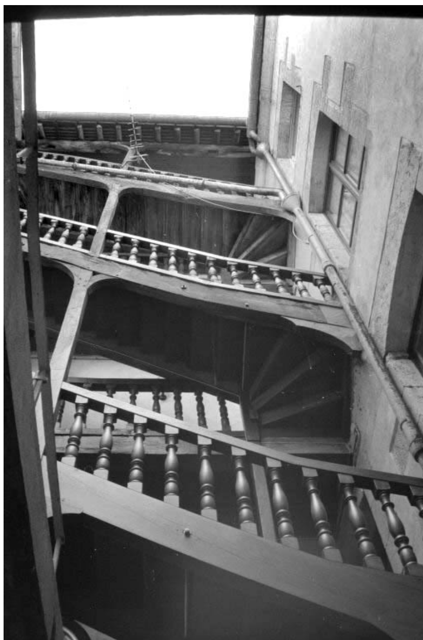
Escalier de distribution extérieur (D).
