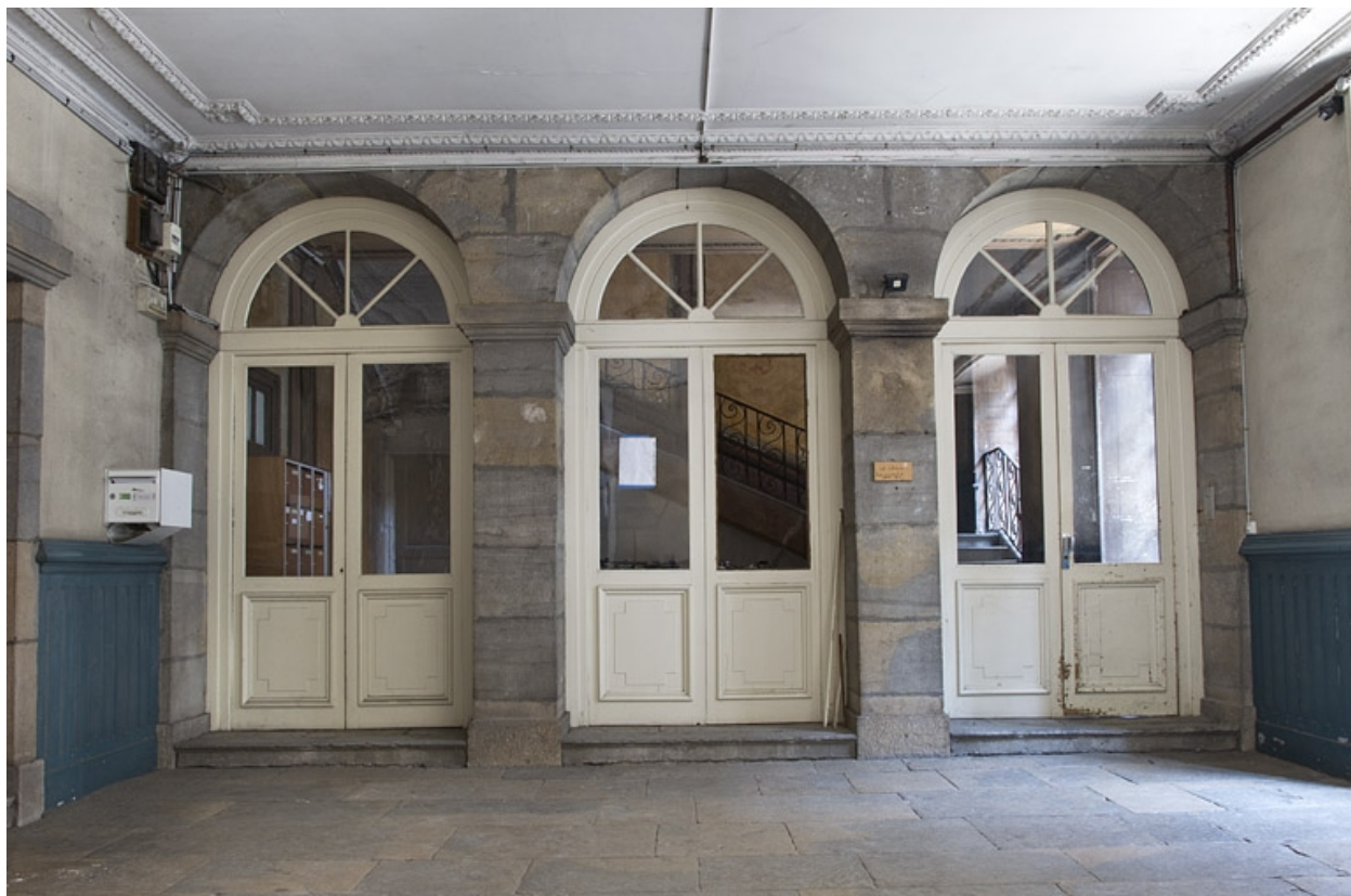
Vue de l'entrée de l'escalier, de face.
