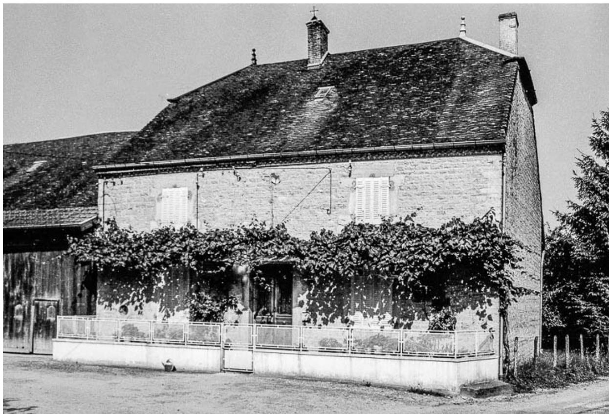
Ferme cadastrée 1811 D1 : façade antérieure de l'habitation.
