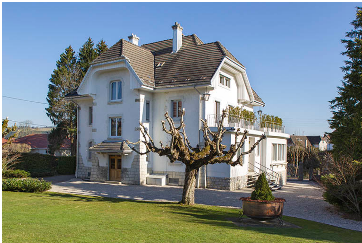
Façades postérieure et latérale gauche.
