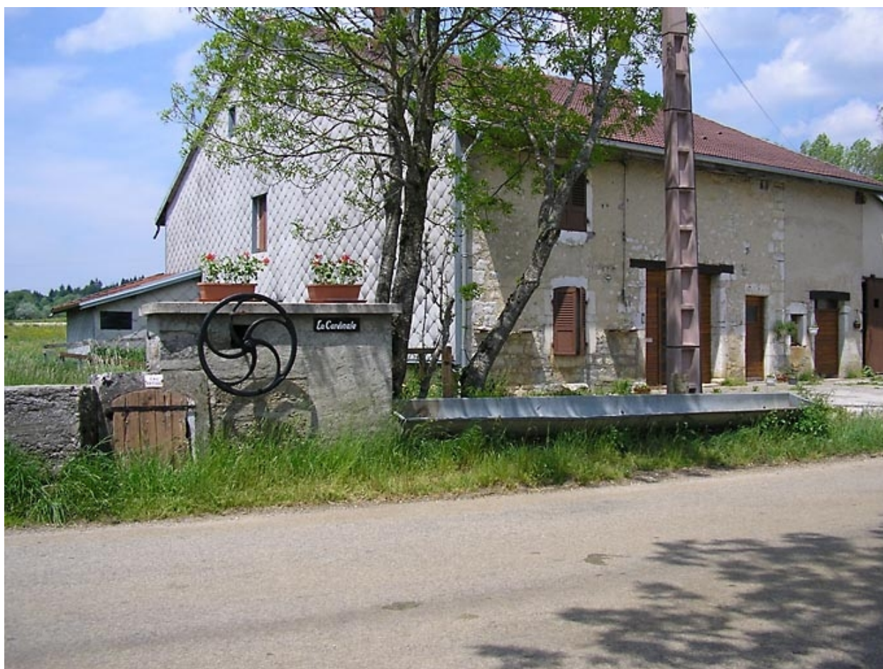
Fontaine-citerne-abreuvoir située Grande Rue, au lieu-dit Les Croyets.
