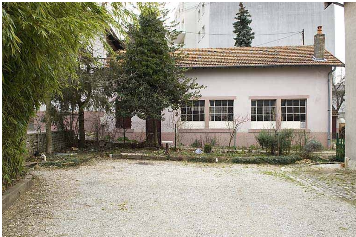
Façade ouest de l'atelier de fabrication.
