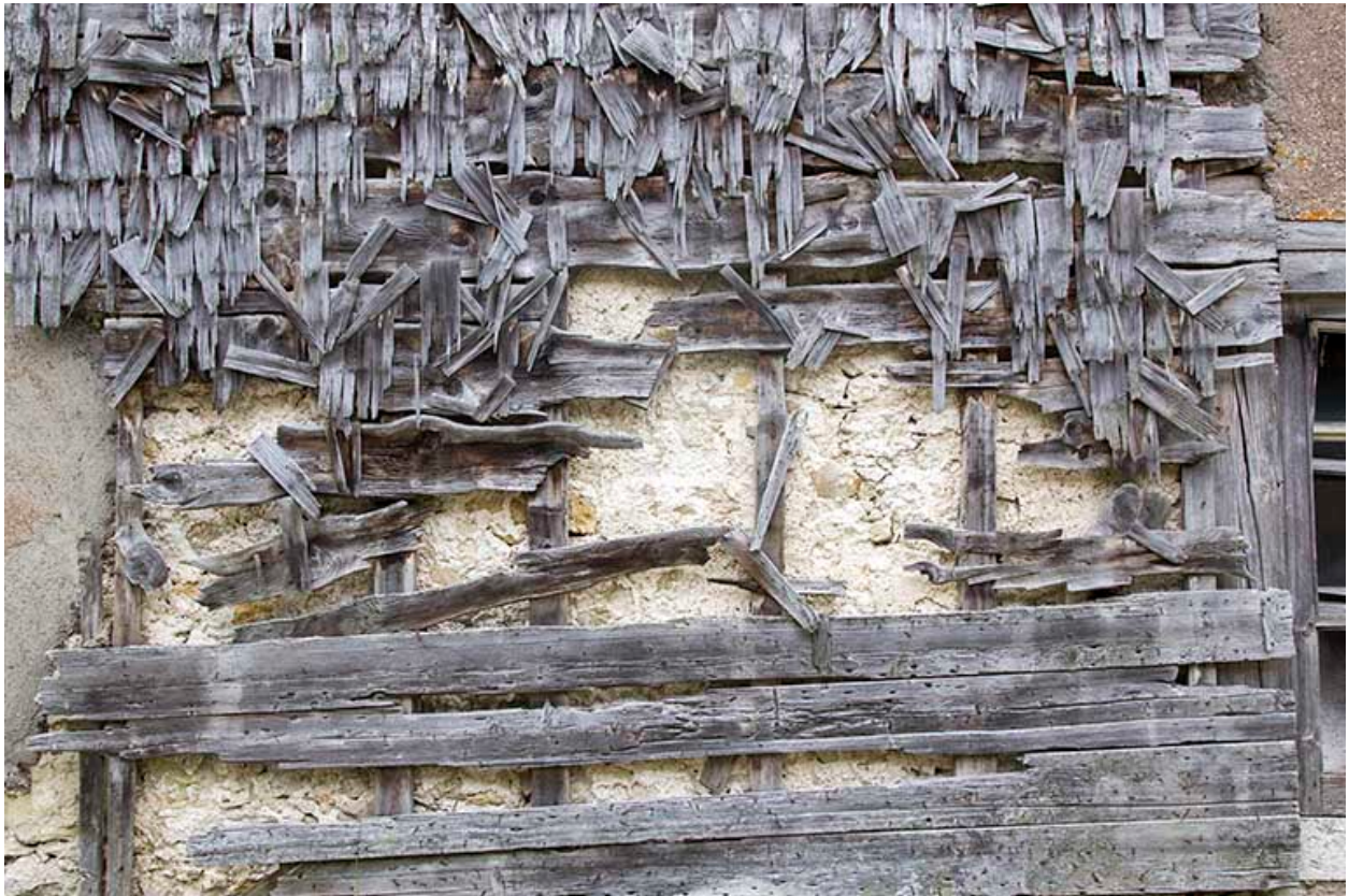
Façade postérieure : vestiges de l'essentage de tavaillons.
