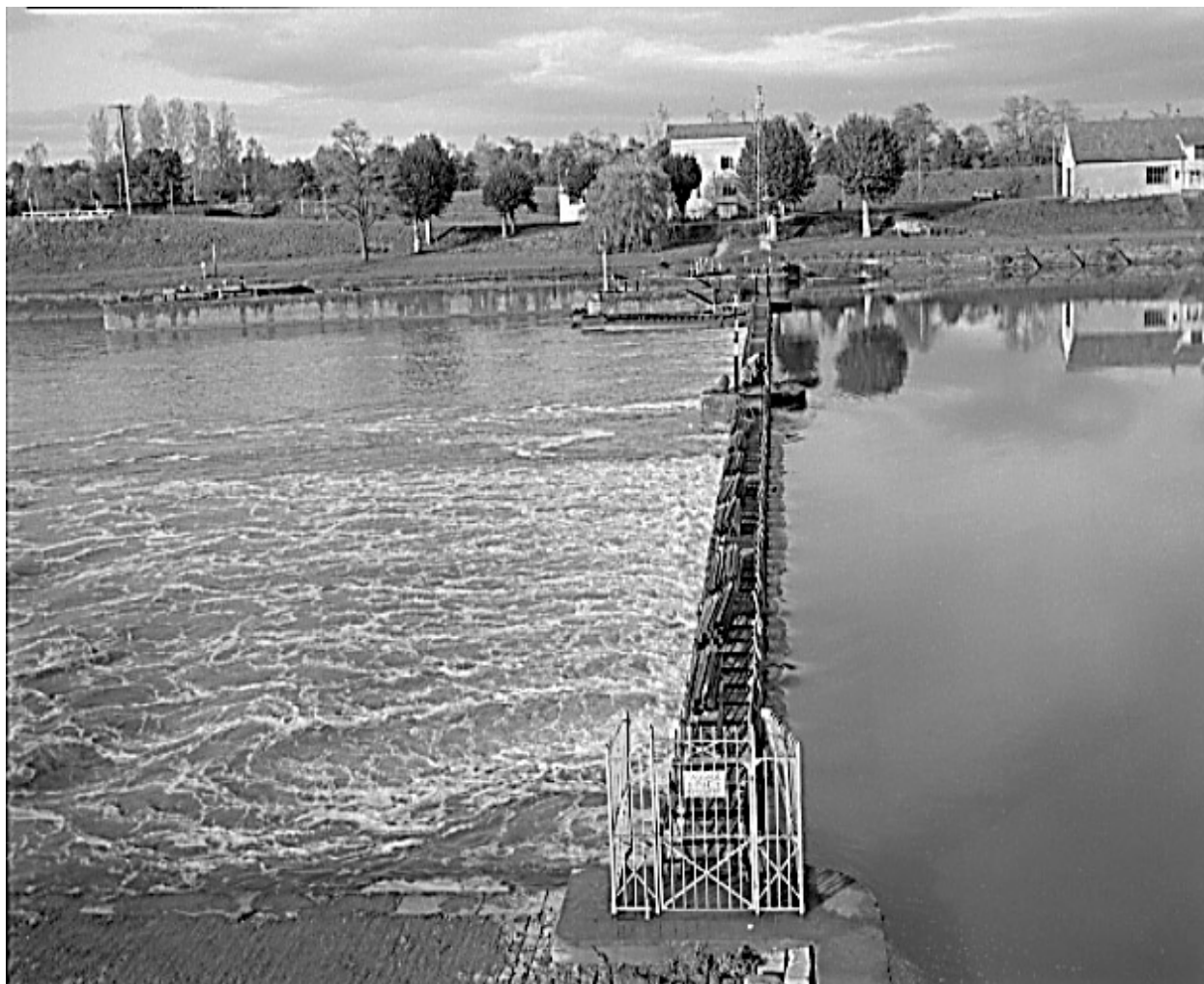
Vue d'ensemble du barrage (en 1986).
