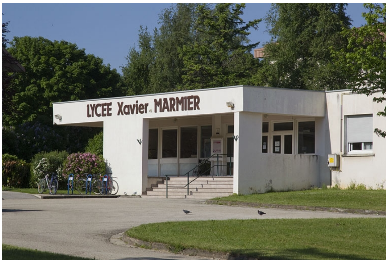
Bâtiment de l'administration : entrée.
