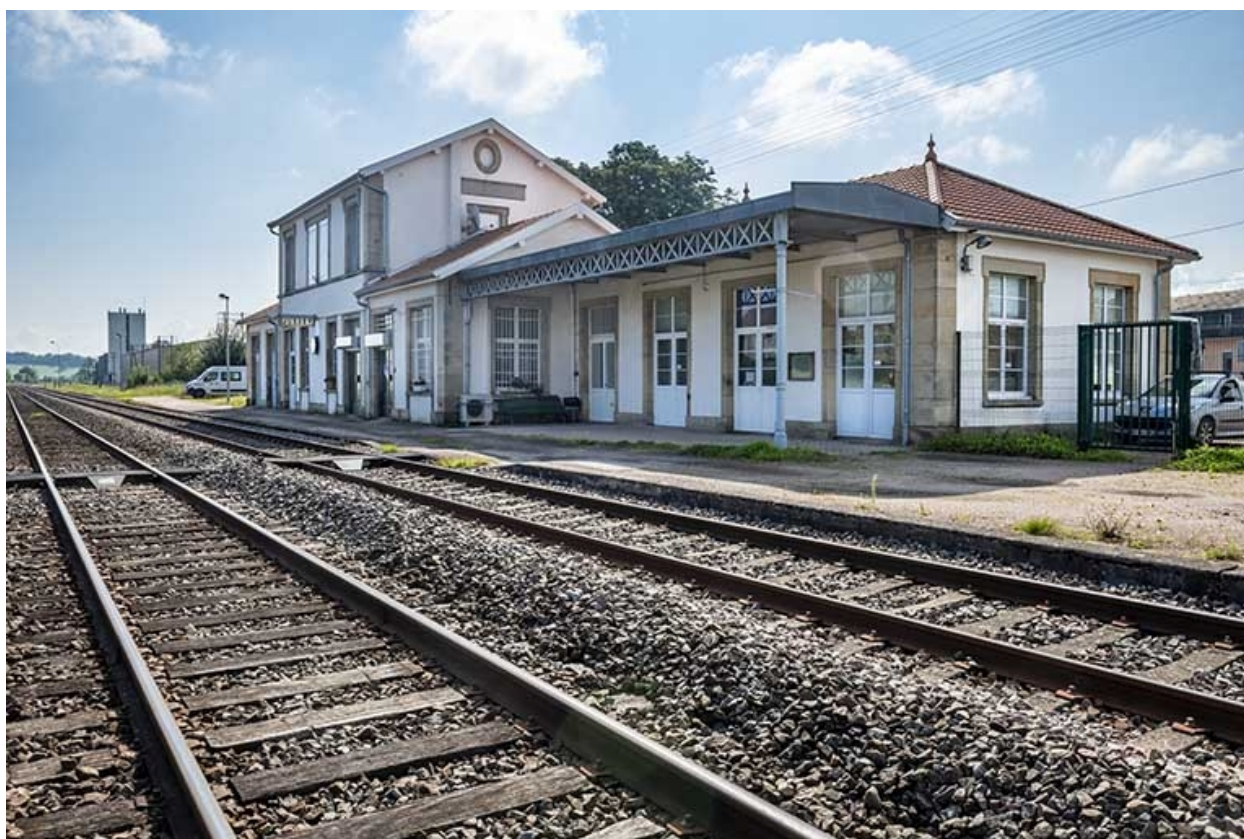
La gare, vue éloignée depuis les voies.
