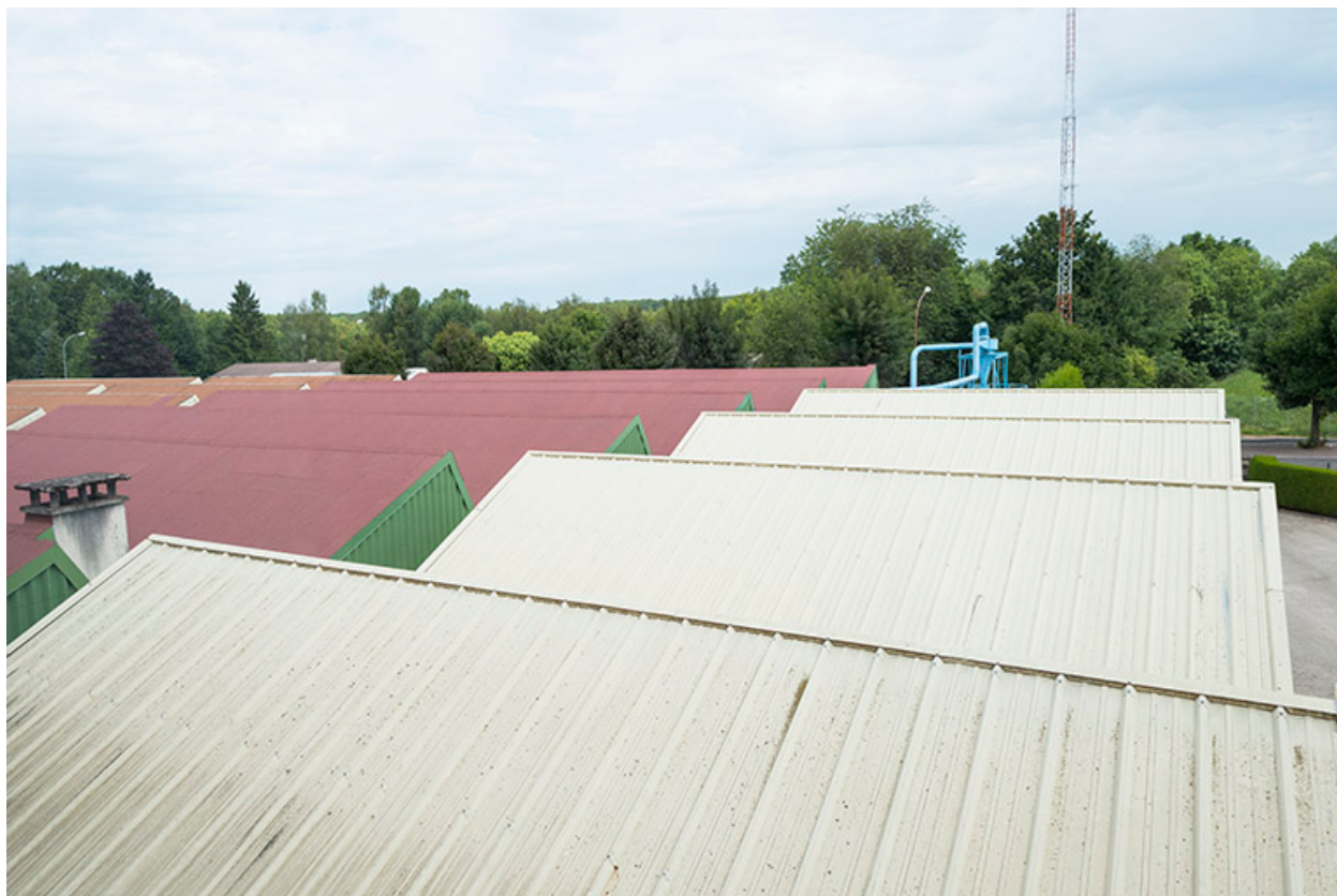
Toitures des ateliers : détail
