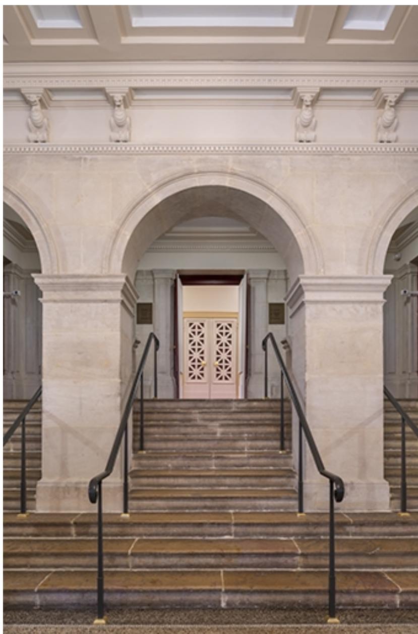
Vestibule : travée centrale de l'escalier.
