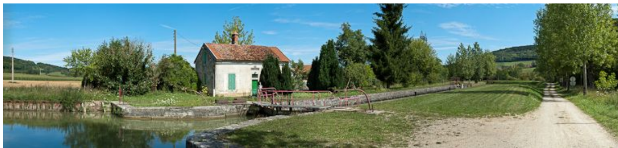
Vue d'ensemble du site d'écluse.
