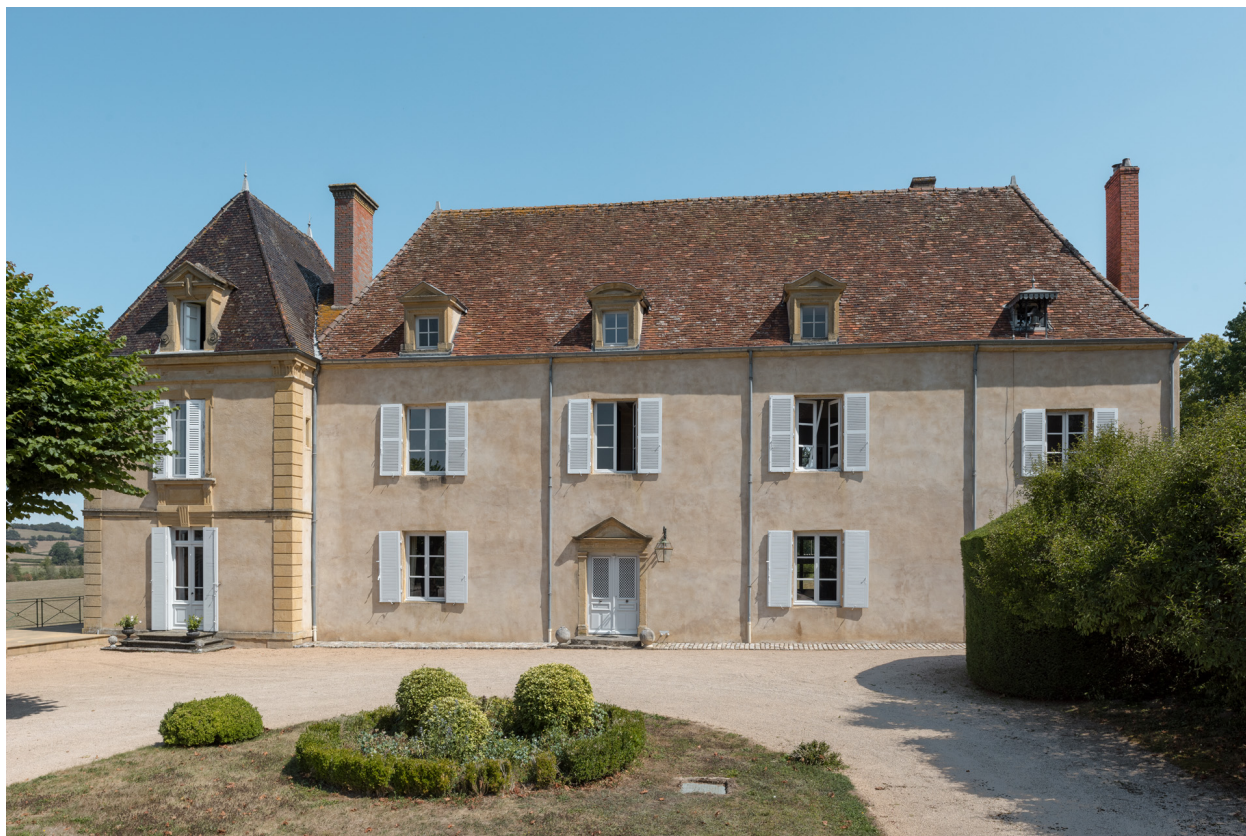
La façade antérieure : vue d'ensemble.
