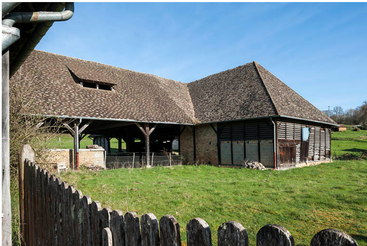
Le bâtiment du four et l'entrepôt industriel vus de trois quarts.
