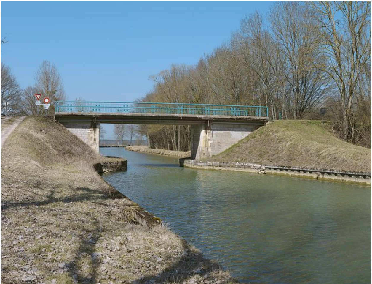
Vue d'ensemble du pont.
