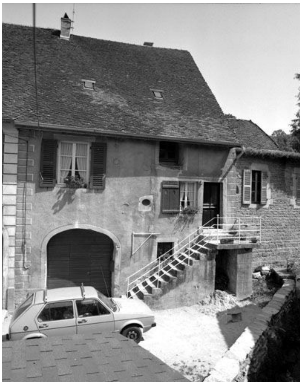
Façade antérieure vue de face.
