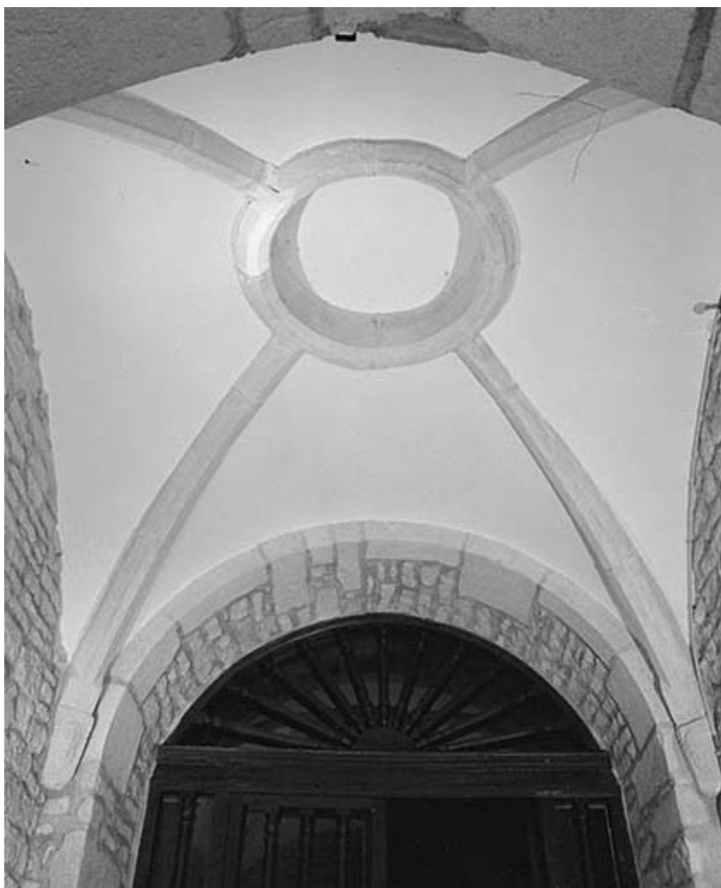
Intérieur : voûte du vestibule.
