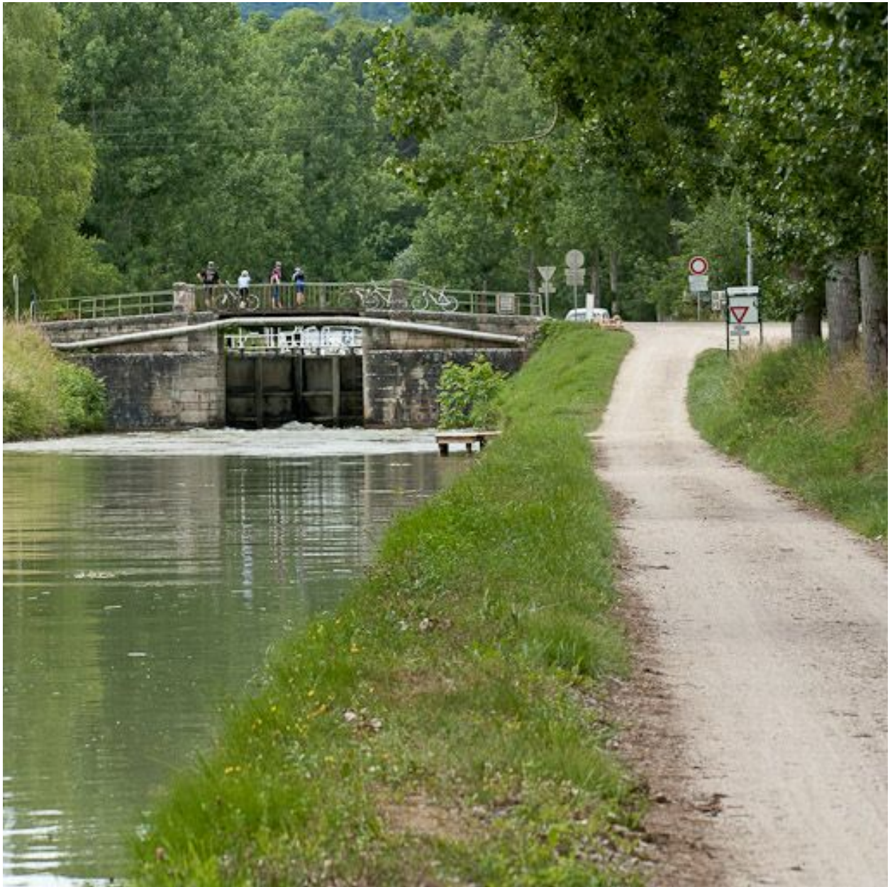
Vue du pont sur écluse.
