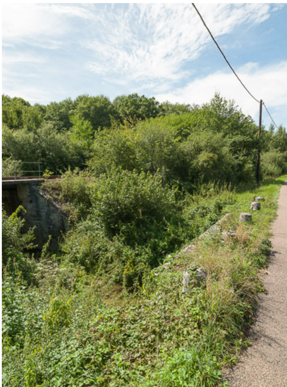
Vue de l'aqueduc.
