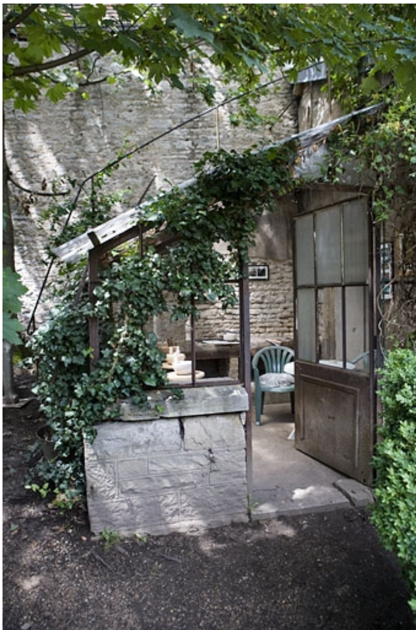
Détail de l'entrée de la serre.
