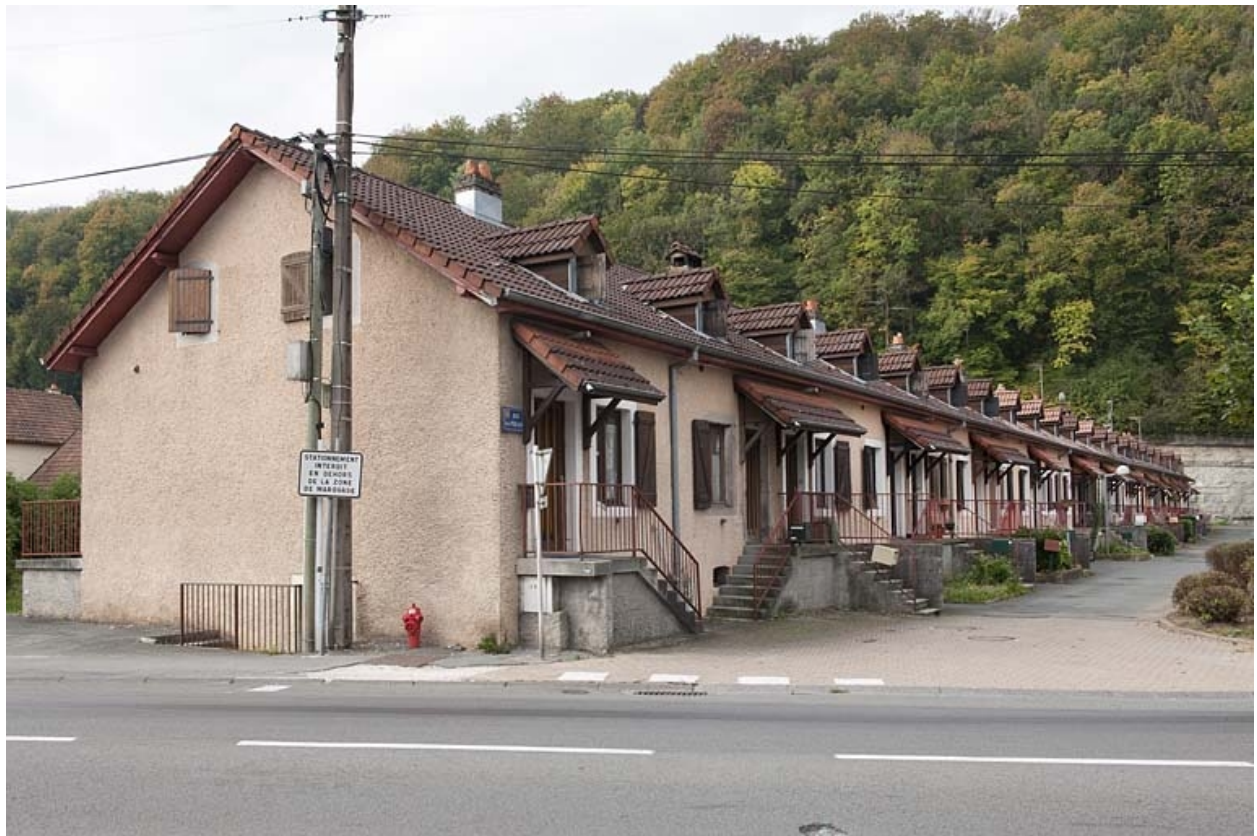
Caserne F. Vue depuis la route départementale.
