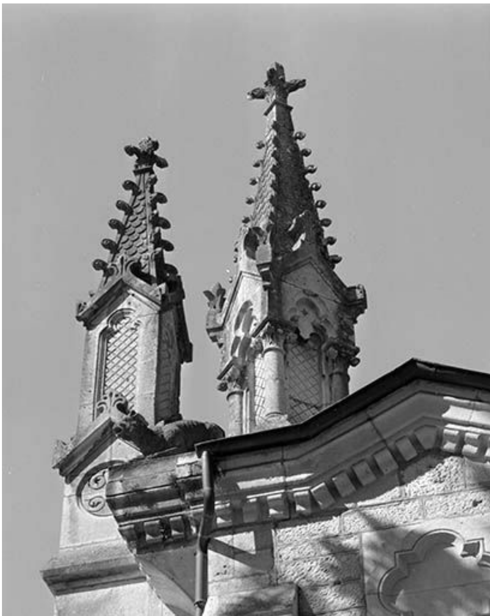
Façade antérieure, détail : les clochetons.
