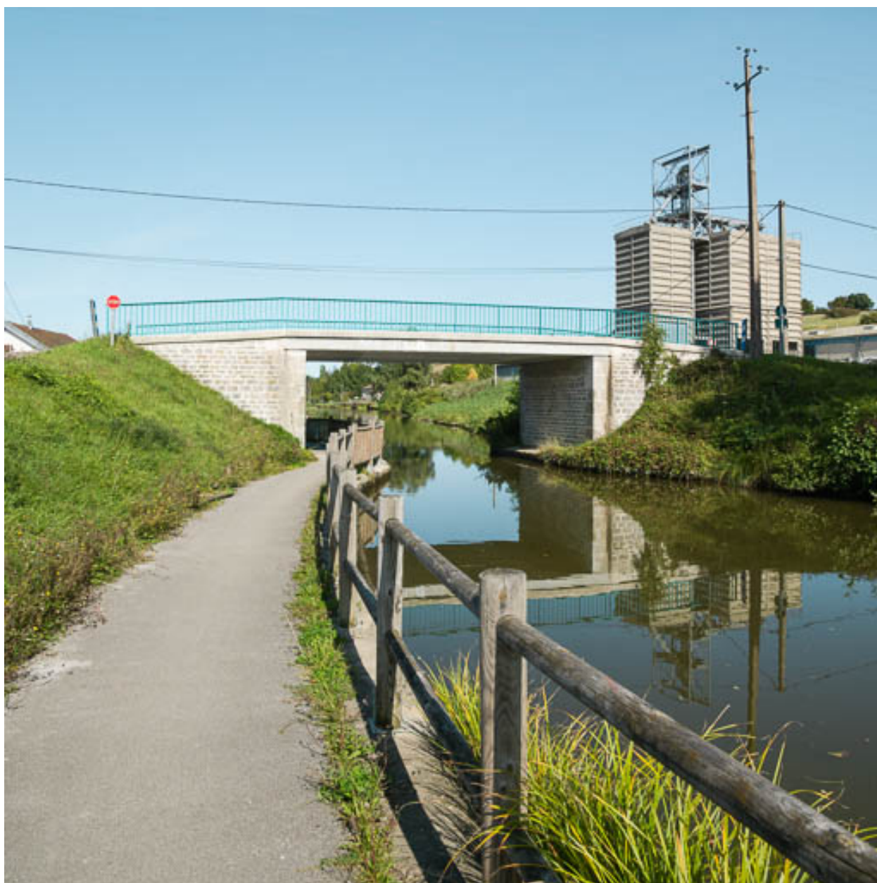
Vue d'ensemble du pont.
