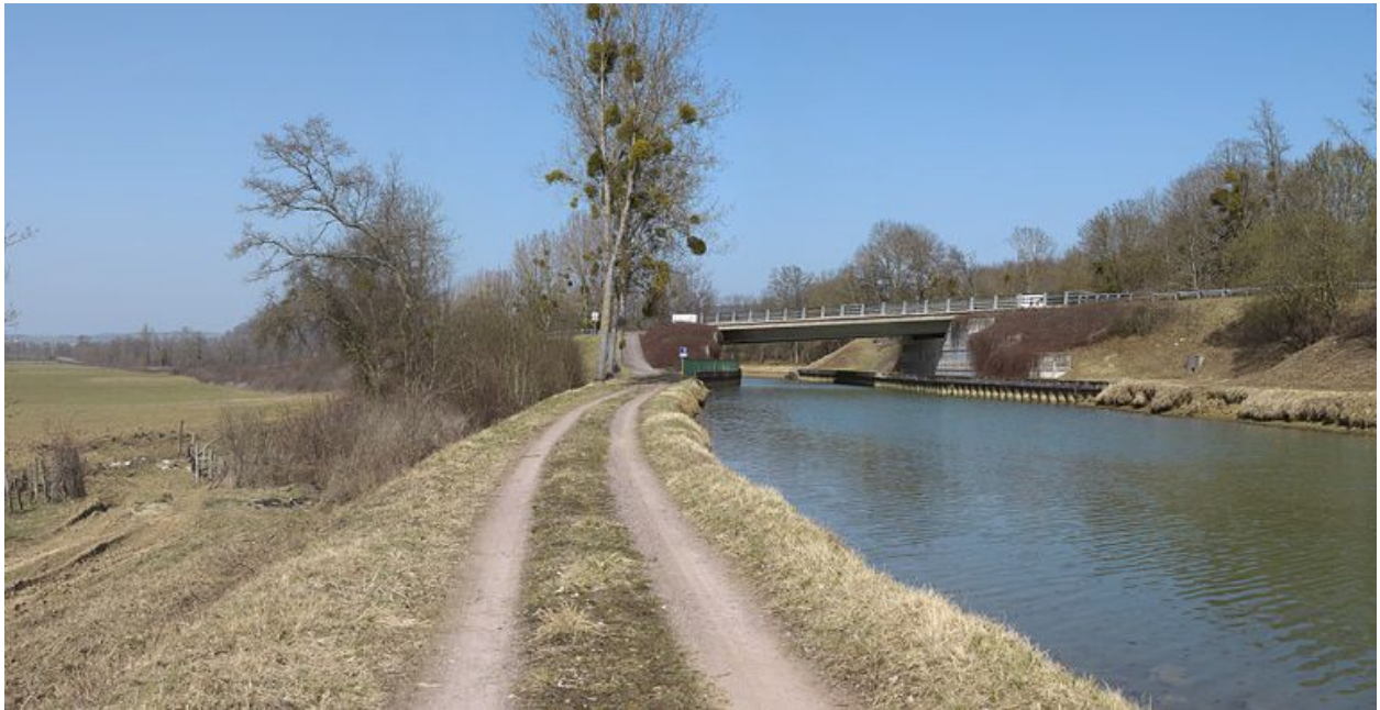
Vue d'ensemble du pont.
