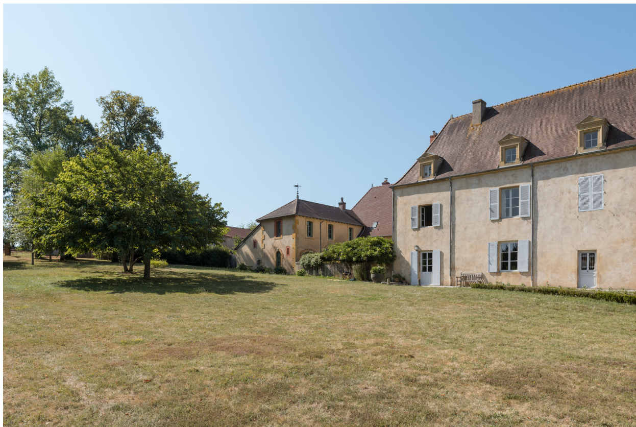
Vue d'ensemble des façades orientales postérieures.
