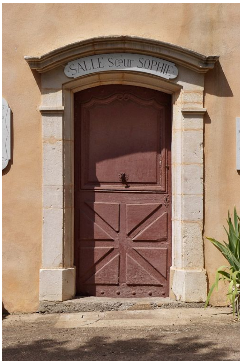
Façade antérieure, porte centrale.
