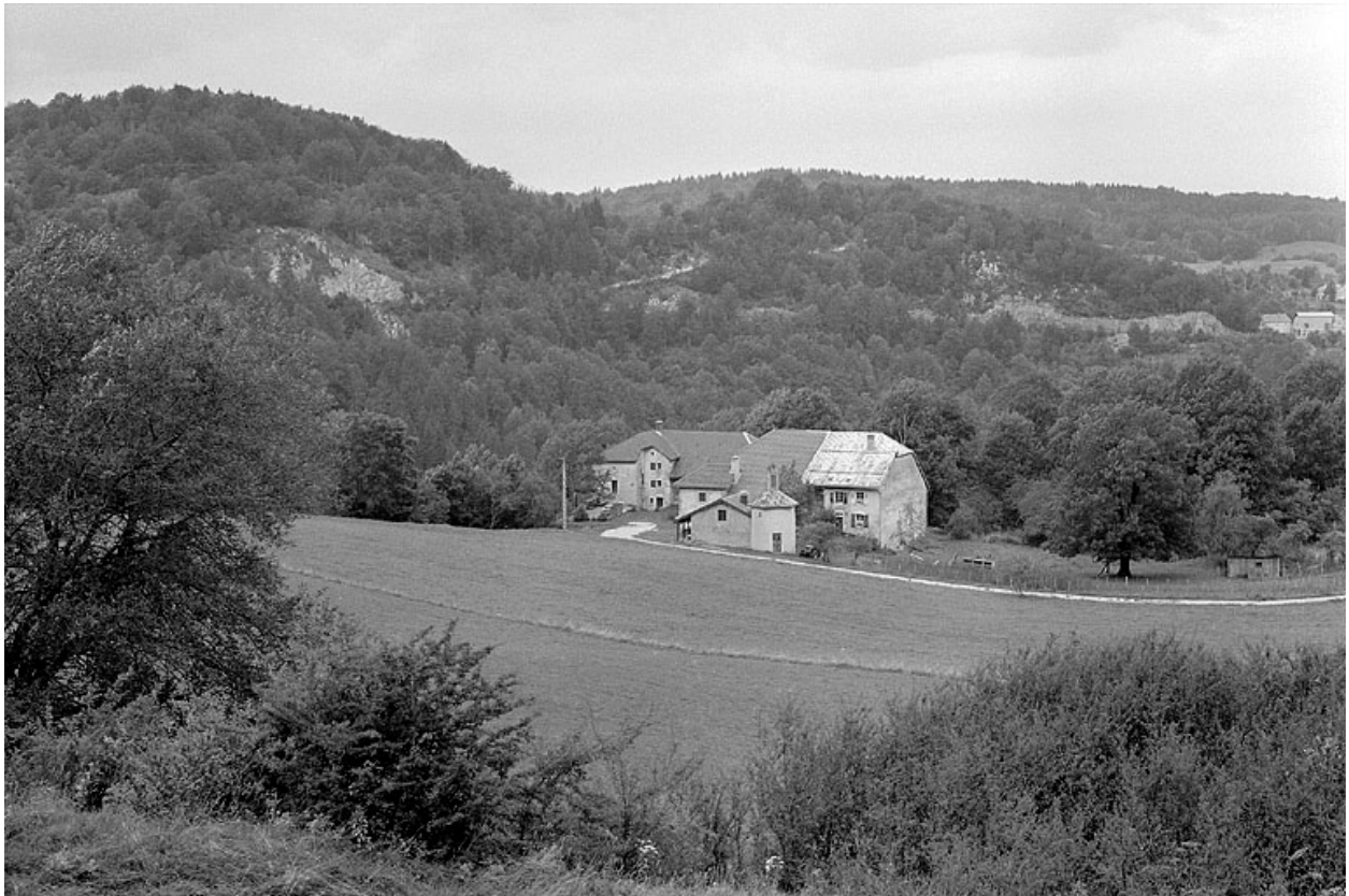
Vue générale, façade sud-est.
