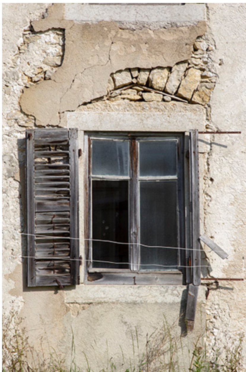
Façade latérale gauche : fenêtre surmontée d'un arc de décharge.
