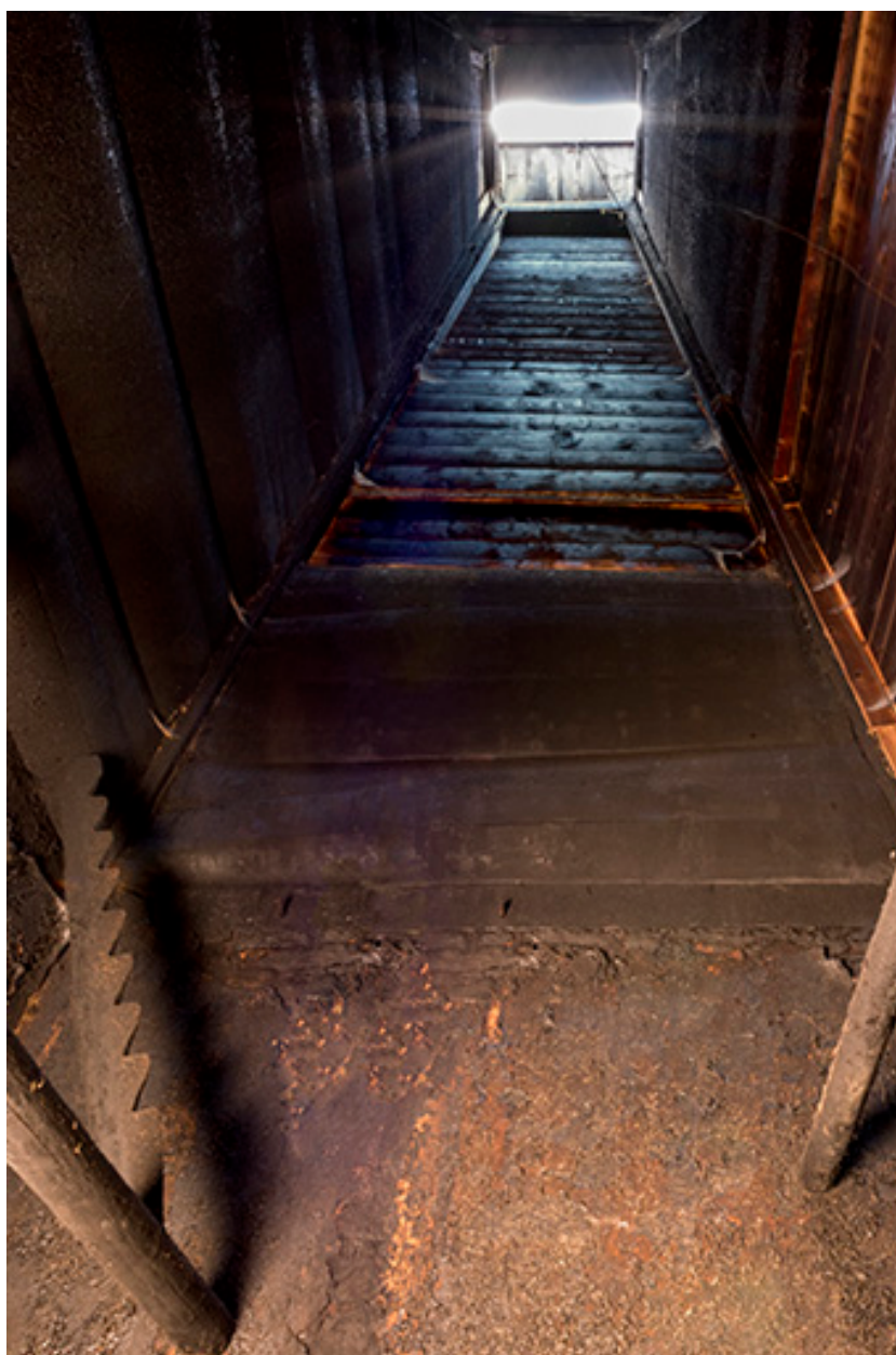
Grand tué : supports des perches et conduit.
