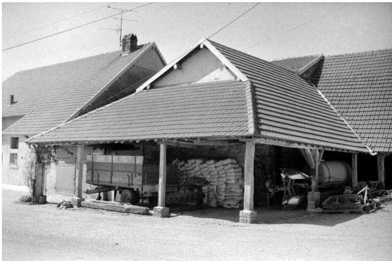
Corps de bâtiment abritant le 1er four.
