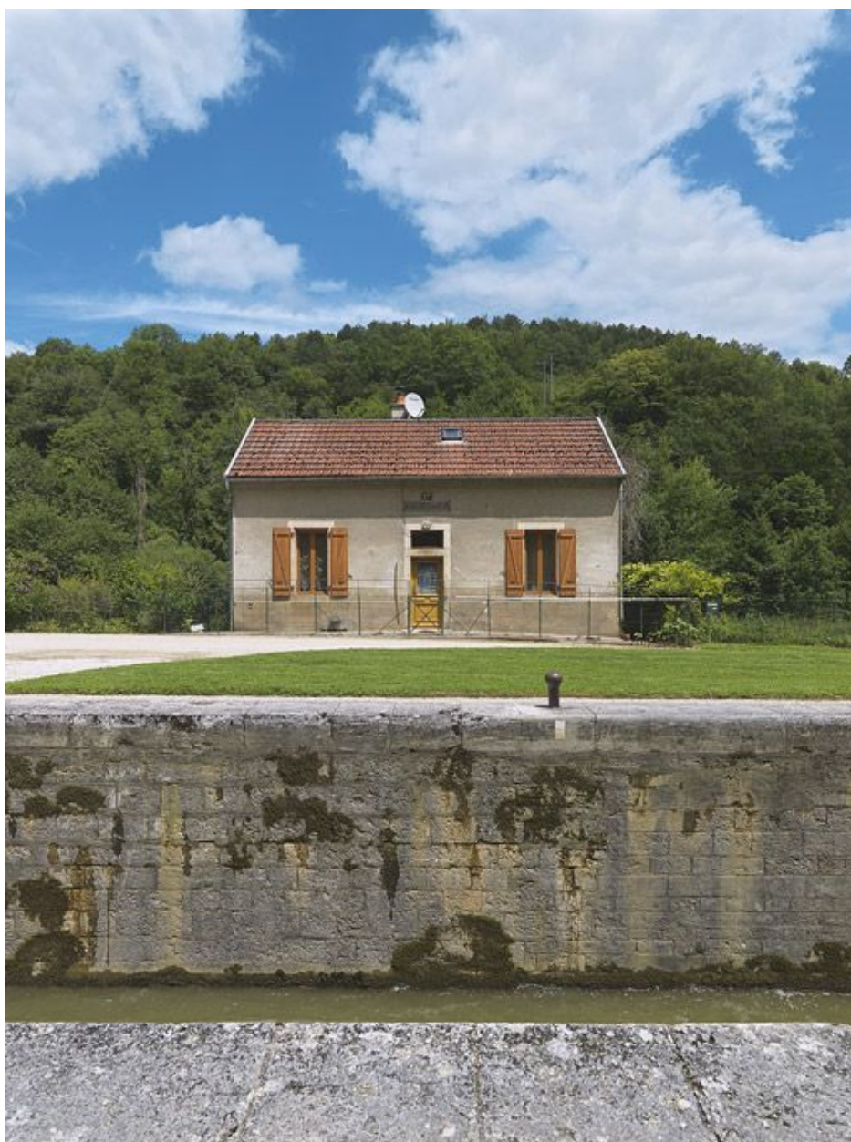
Maison éclusière de face.
