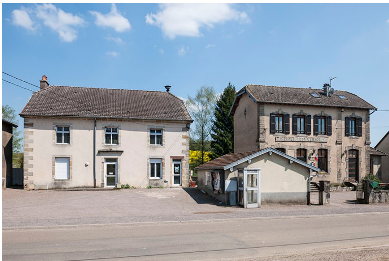
Vue d'ensemble avec l'ancienne école.
