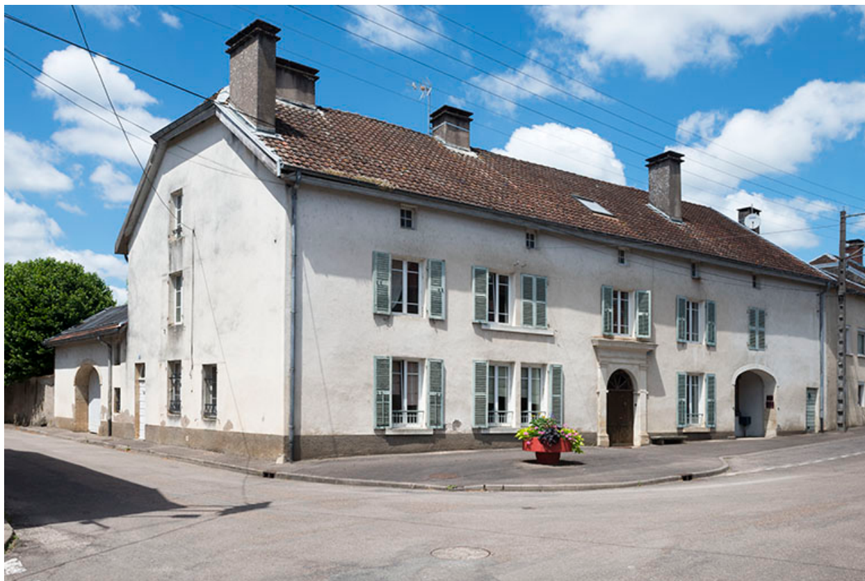
La façade antérieure : vue d'ensemble.
