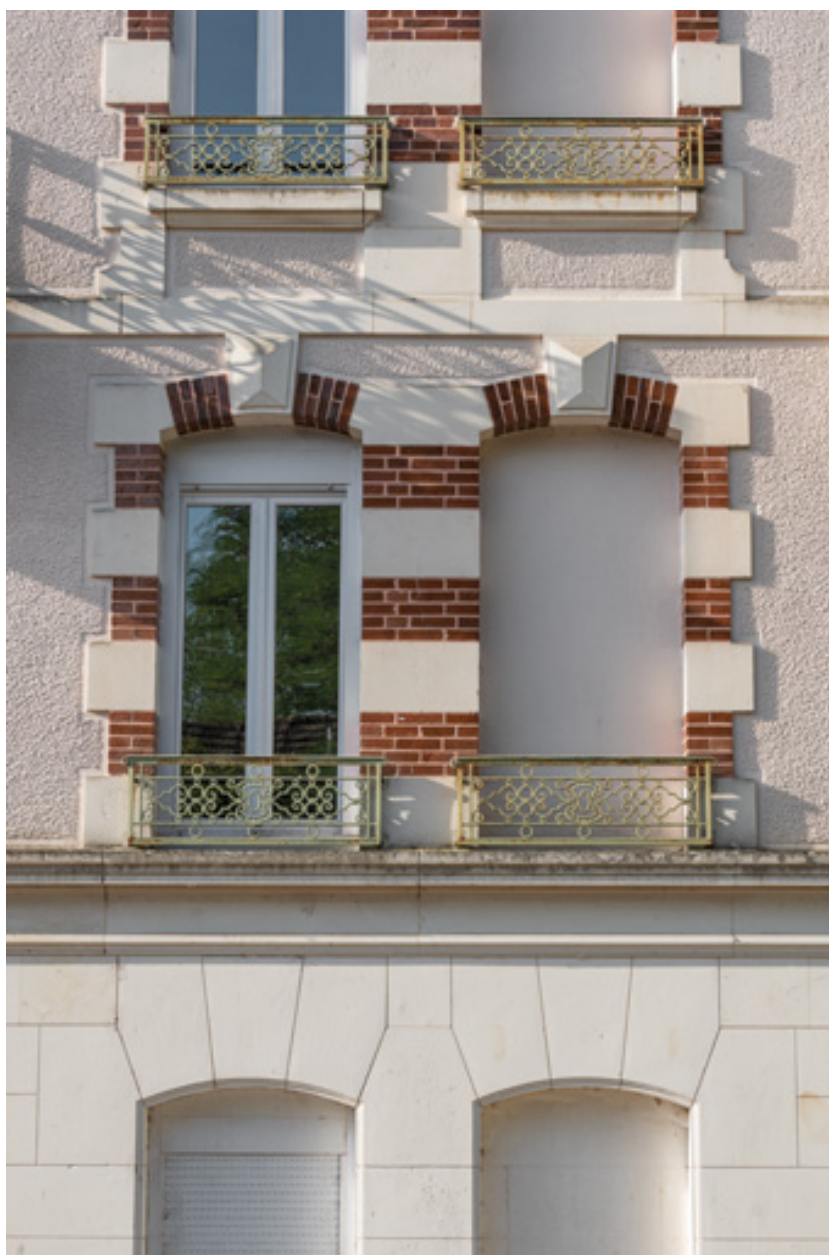
Pavillon occidental, encadrements de baies.
