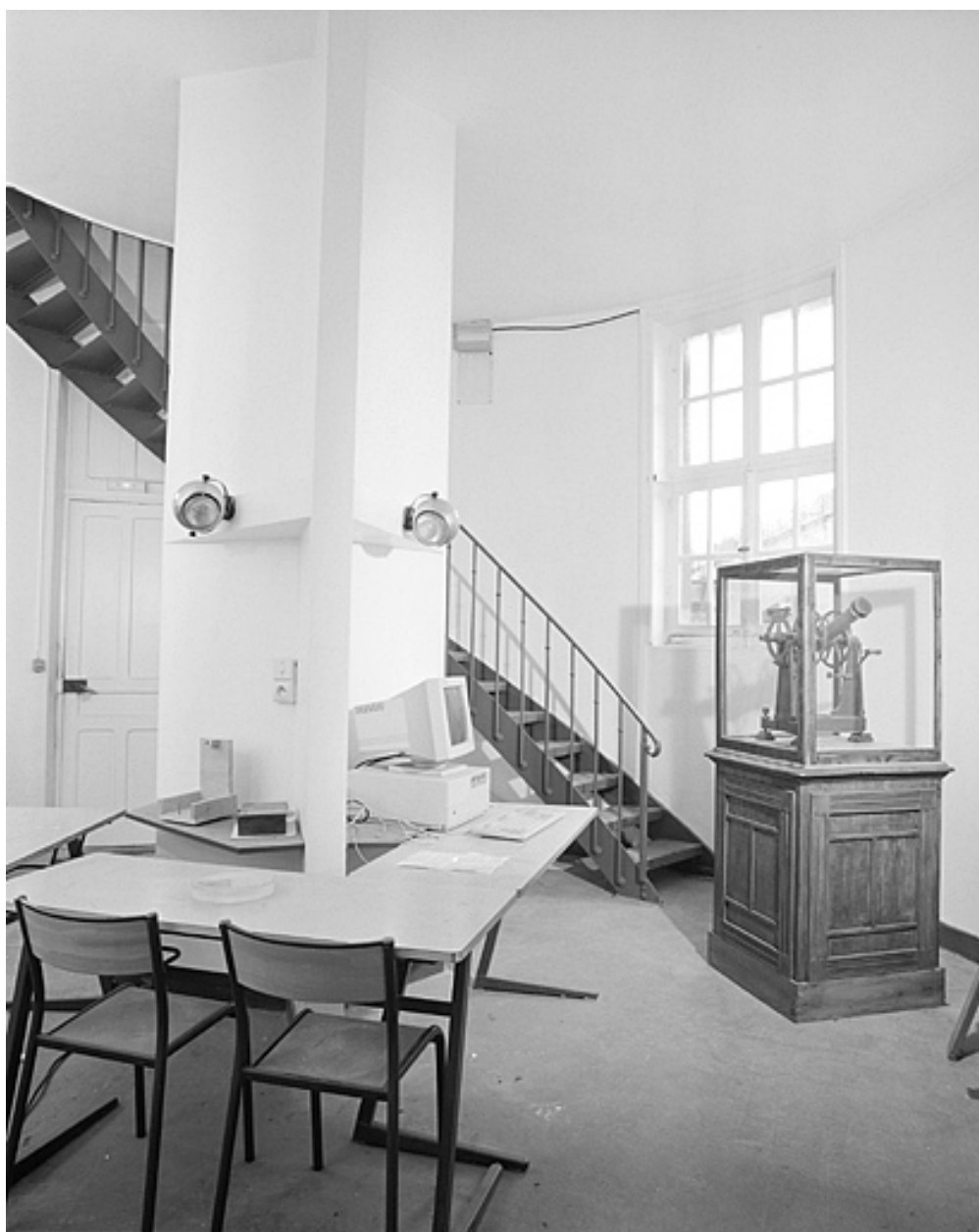
Pilier triangulaire supportant la lunette et escalier d'accès au dôme.
