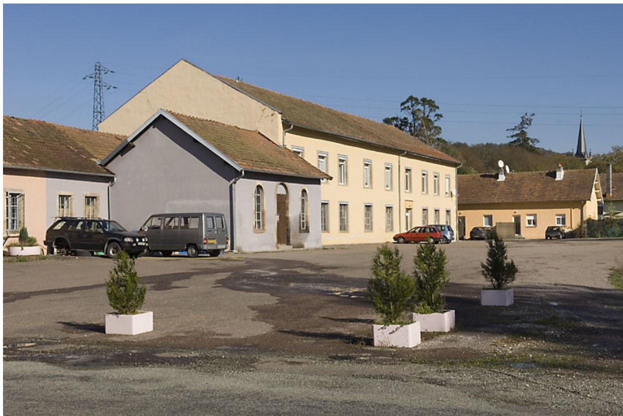
Façades sud. Chaufferie et atelier de fabrication (?).
