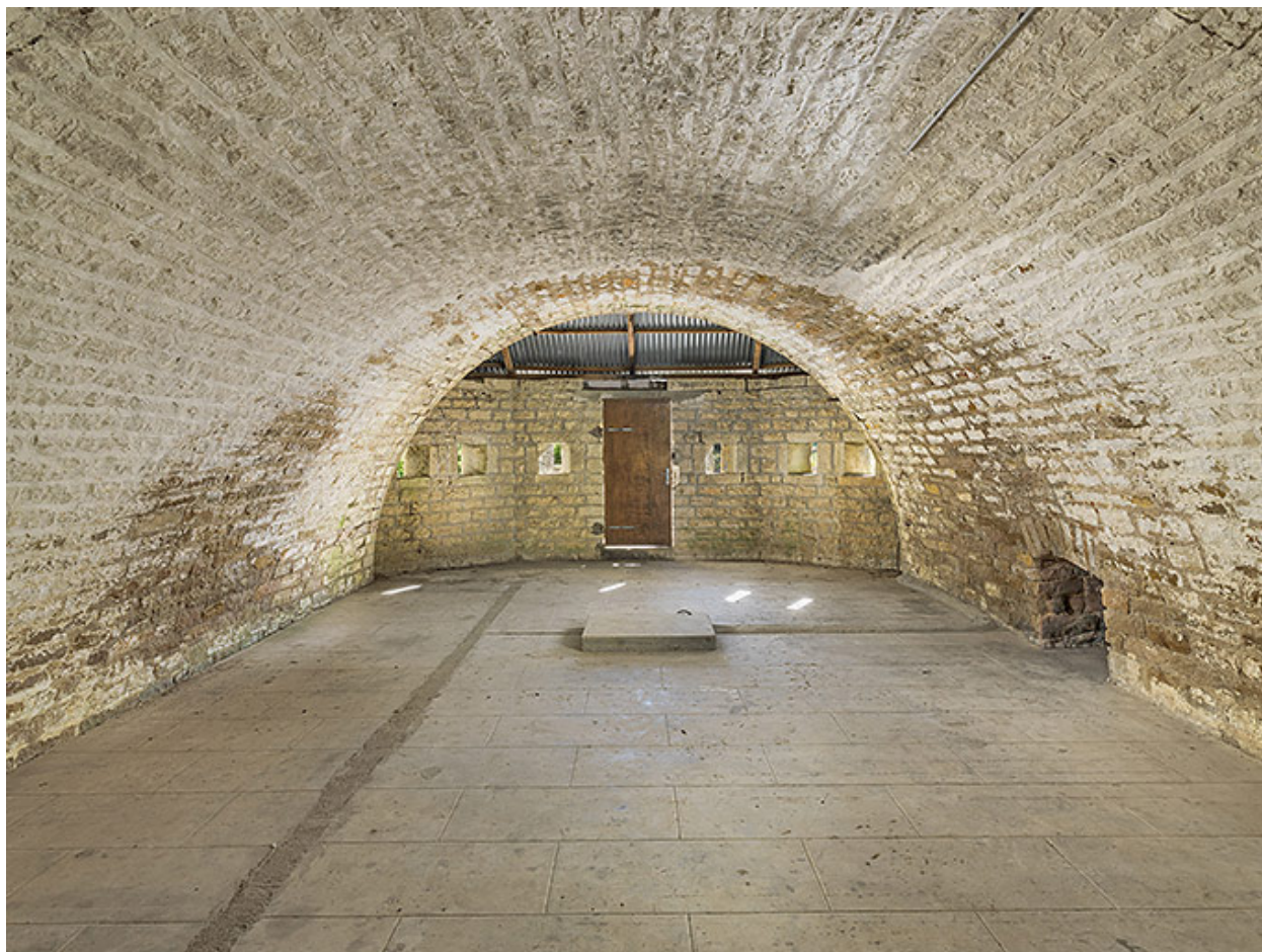
Vue intérieure de la traverse en direction de l'ouverture retranchée (présence d'embrasures).
