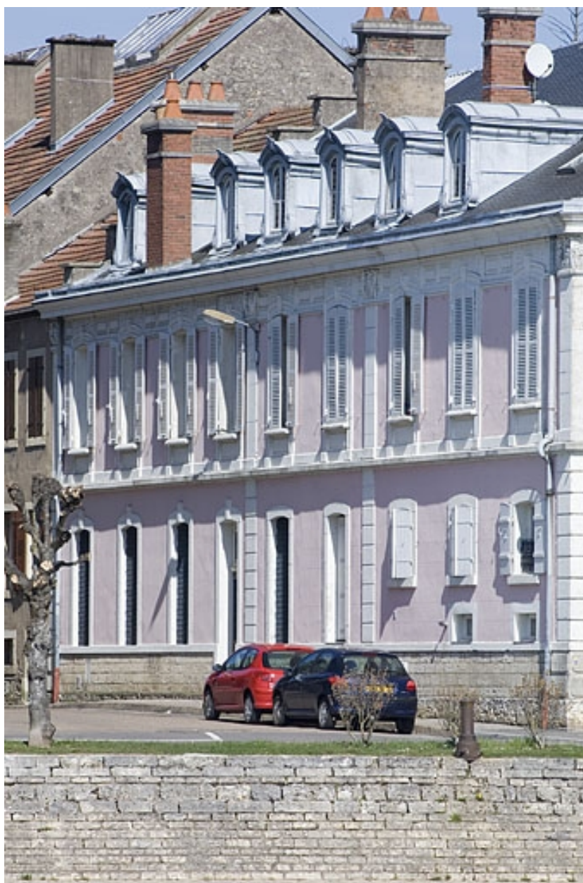
Façade ouest du logement patronal.
